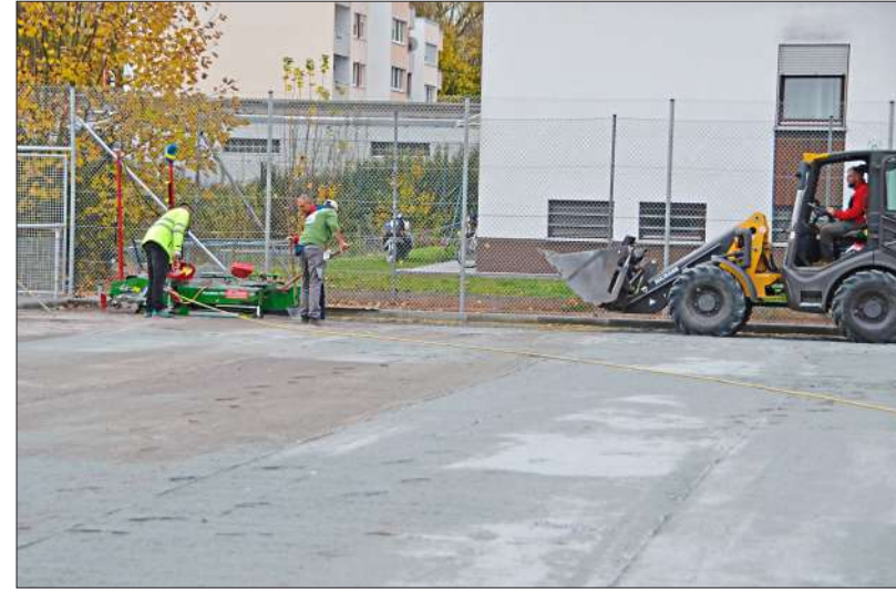
Die letzten Bauarbeiten am Untergrund. Diese Maschine rüttelt das Material und zieht es in einem Arbeitsgang glatt ab.
